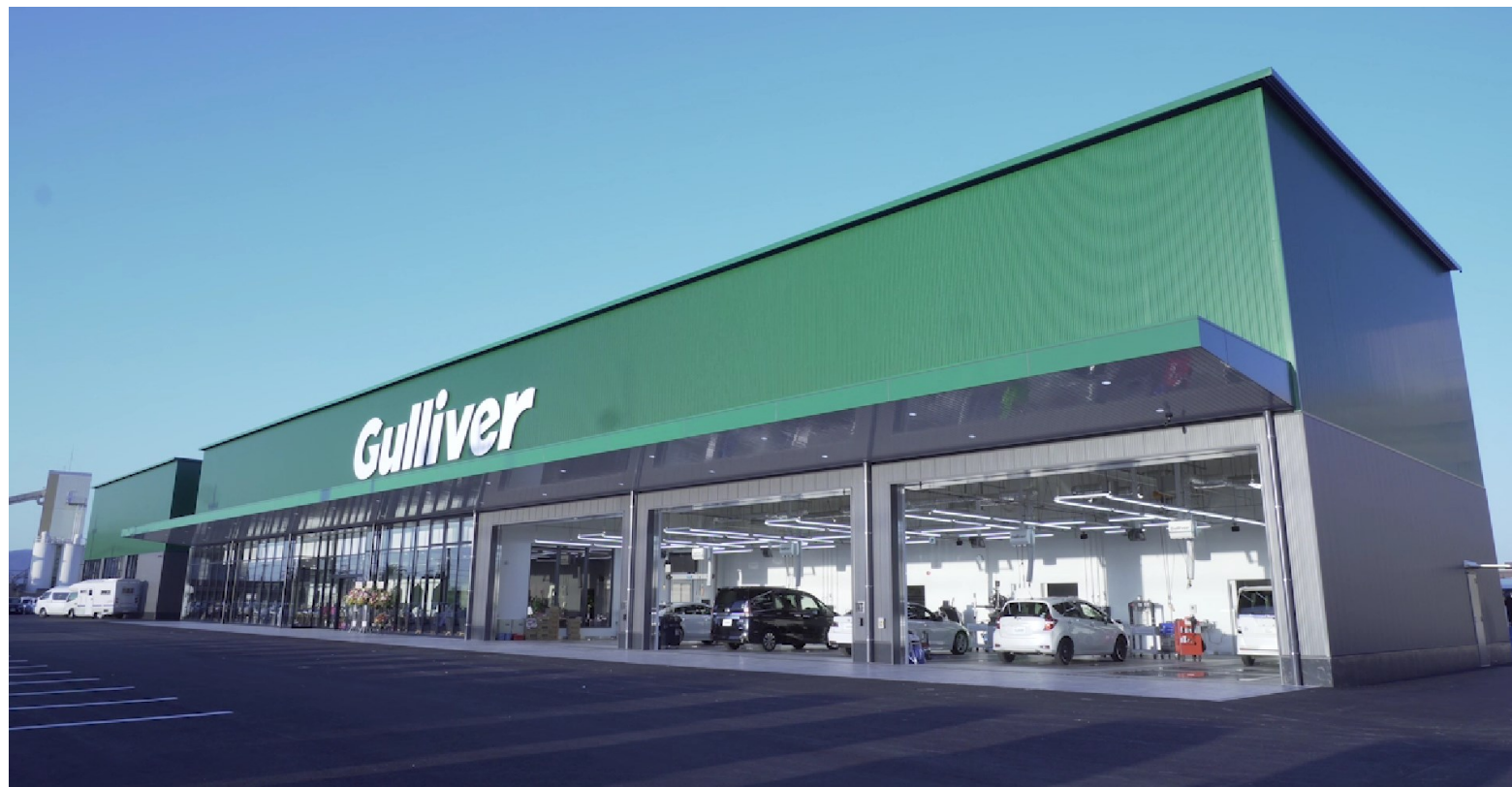
宮崎港整備工場（2022年2月オープン） 宮崎県宮崎市
