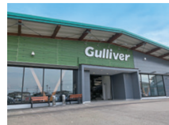
小山整備工場
