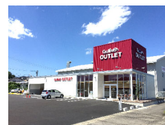
OL10号延岡 宮崎県延岡市
