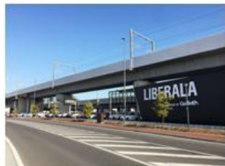
リベラーラ仙台 宮城県仙台市
