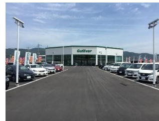
和歌山バイパス 和歌山県和歌山市
