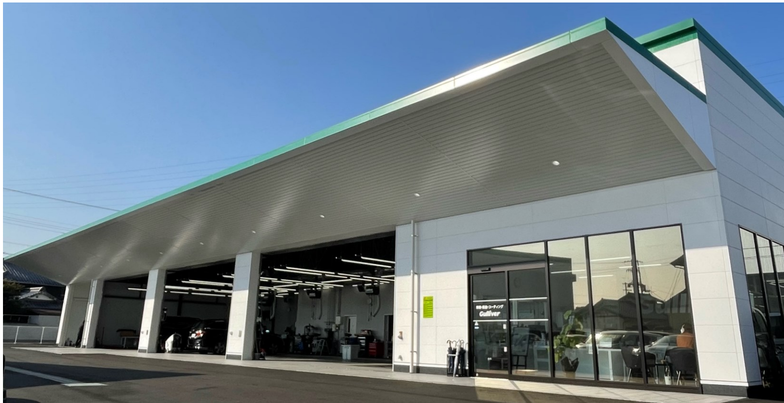
高松東山崎整備工場（2022年9月オープン）
