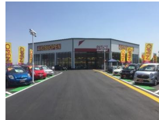
OL岸和田和泉インター 大阪府和泉市
