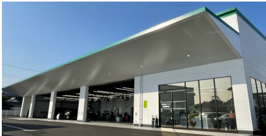
高松東山崎整備工場（2022年9月オープン）
